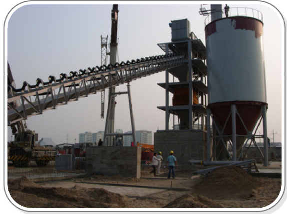
BP & SILO SITE ERECTION
